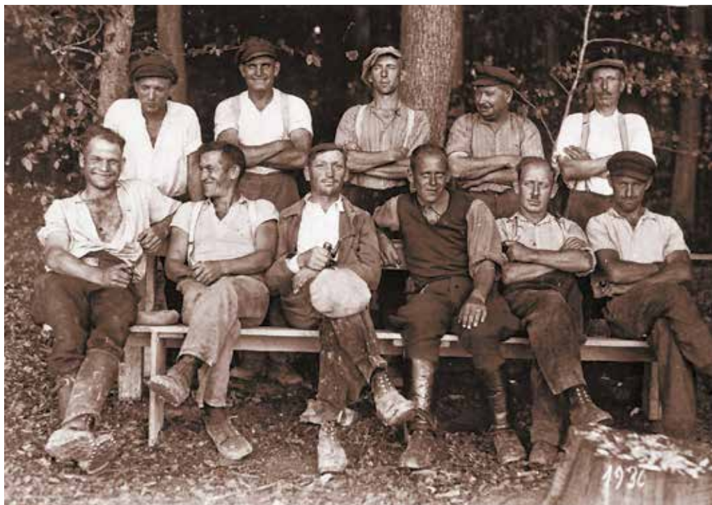
Arbeiter der Rodung bei Bölingen 1936
