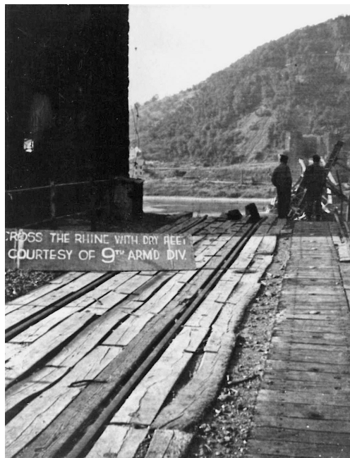
Die Zufahrt zur Remagener Brücke kurz nach dem Einsturz am 17. März 1945
