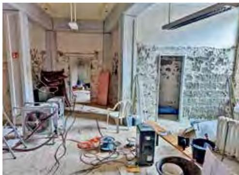
*Unmittelbar nach der Flutkatastrophe haben freiwillige Helfer den nassen Putz von den Wänden im Erdgeschoss des Altenahrer Rathauses gestemmt. Im weiteren Verlauf stellte sich heraus, dass unter anderem Heizöl tief in das Mauerwerk eingedrungen ist. Ein Konzept zu finden, die Wände zu tauschen, ohne dabei die denkmalgeschützte Fassade des Rathauses zu gefährden, ist eine Herausforderung.*
