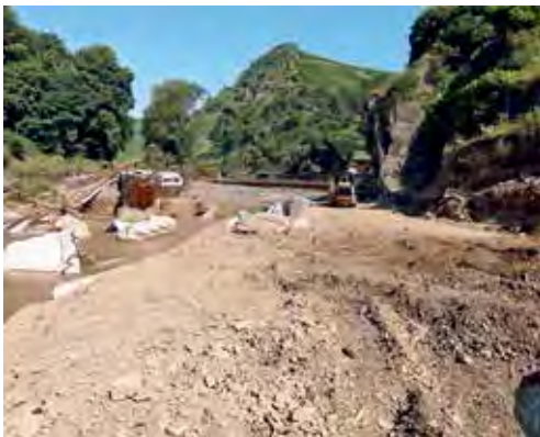
Die B 267 führt an der Ahr entlang von Altenahr über Mayschoß, Walporzheim und vorbei am Felsvorsprung „Bunte Kuh“. Aufnahmedatum: 21. Juli 2021
