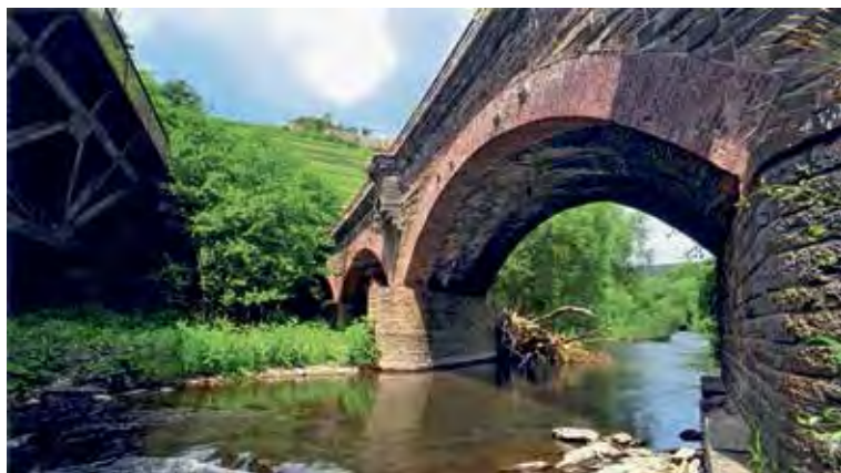
In Mayschoß: Die Eisenbahnbrücke von 1905 und die Radwege-Bogen- brücke von 1904, beide intakt (ca. 2012) ...
