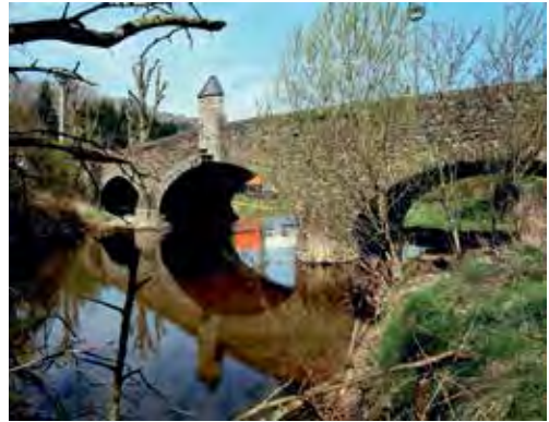
Die Ahr-Brücke in Antweiler (ca. 2012)
