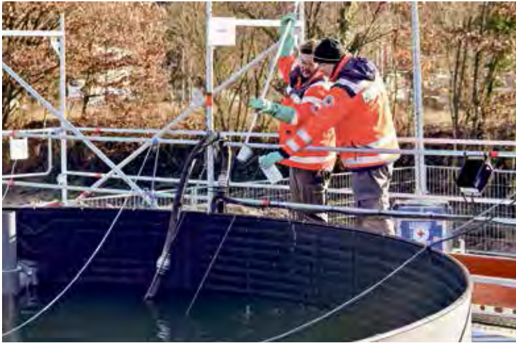
DRK-Experten entnehmen eine Wasserprobe an der temporären Kläranlage Hönningen für das DRK-Abwasseranalytik-Labor.
