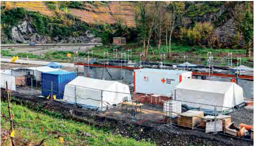
Die temporäre DRK-Kläranlage in Mayschoß wurde im August 2021 in nur zwei Wochen errichtet. Im Hintergrund sieht man die zerstörte Kläranlage des Abwasserwerks Mittelahr.
