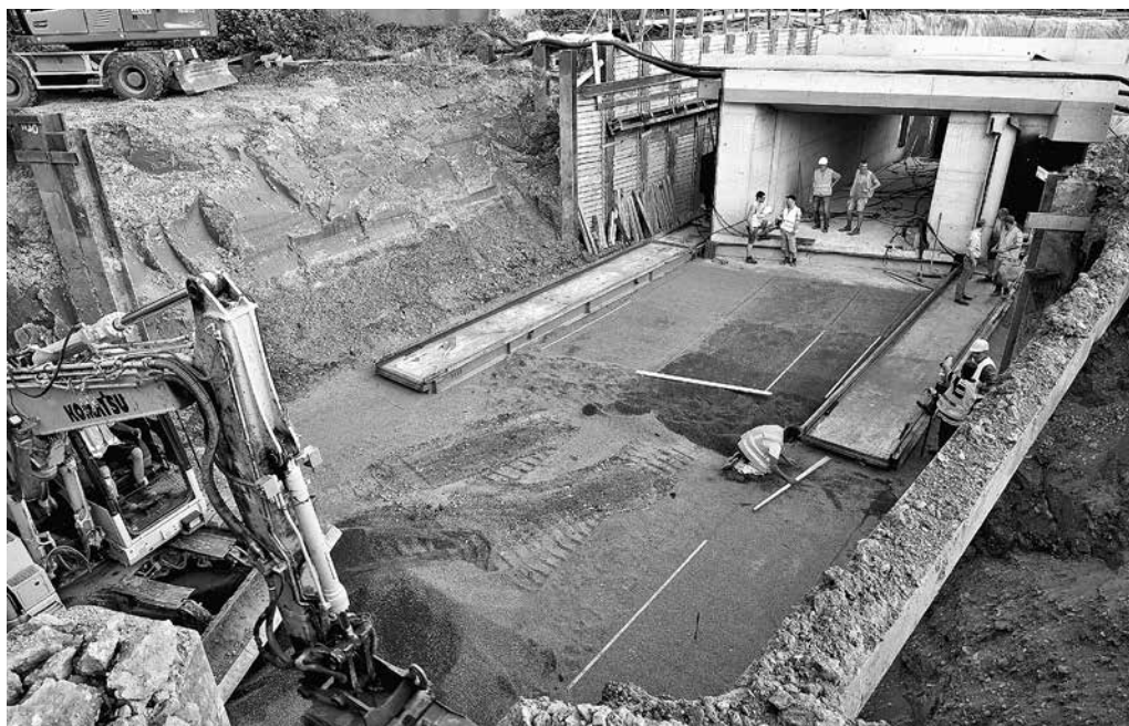
Der frisch gegossene Betontunnel wurde in seine neue Position geschoben.
