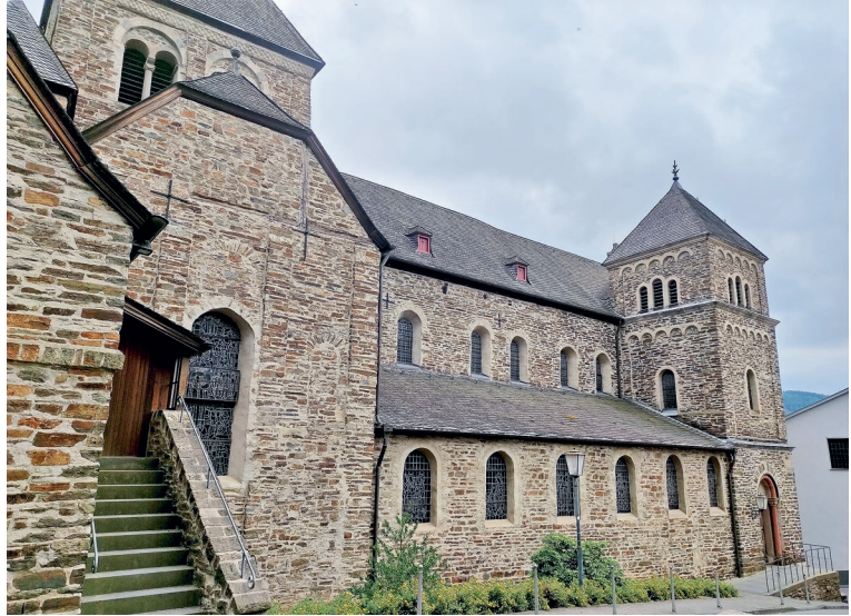
Die Pfarrkirche Altenahr
