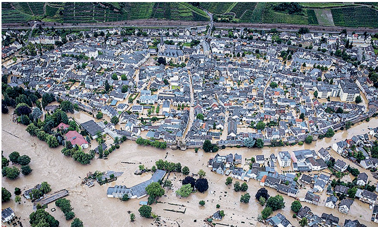
Bad Neuenahr-Ahrweiler. Blick von Süden. Die vom Hochwasser 2021 überflutete Altstadt von Ahrweiler lässt den ovalen Bering mit vorgelagertem Graben der mittelalterlichen Stadtbefestigung erkennen.
