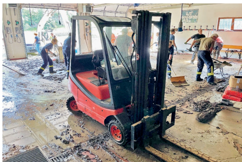
Wenn Rettungskräfte selbst Hilfe brauchen: Aufräumen im Feuerwehrhaus Altenahr nach der Flut
