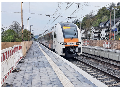
Baustelle mit neuen Bahnsteigen: Am 30. April 2021 fährt der RE 5 nach Wesel in den Bahnhof Oberwinter ein.
