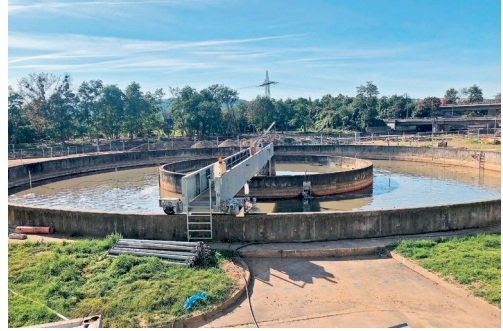
Wieder in Betrieb: die Vorklärung und das Denitrifikationsbecken am 3. August 2022
