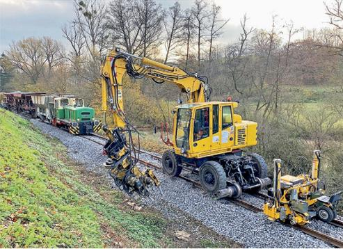
*Zwischen Weiler und Niederzissen wurden im Herbst 2020 die ersten 1,2 km Gleise erneuert. Der neue Schotter wurde per Bahn vom Brohler Hafen her angeliefert und anschließend mit einem Anbaugerät am Bagger erstmals gestopft.*
