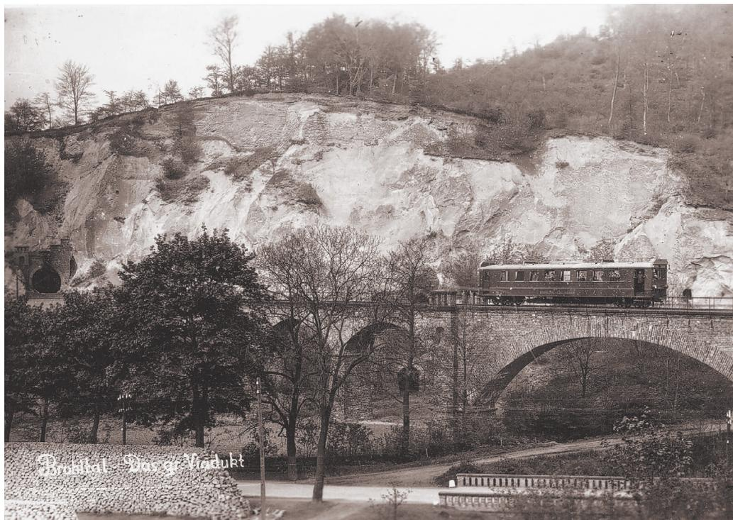
*Die Umstellung des Personenverkehrs auf Triebwagen brachte nicht nur bezüglich der Reisezeiten einen Qualitätssprung. VT 50 (der heutige Salonwagen VB 50) ist hier auf dem Tönissteiner Viadukt zu sehen, im Hintergrund der Tönissteiner Tunnel durch die Trasswand, deren unter dem Viadukt erkennbare Abbau- und Lagerstätten heute als „Trasshöhlen“ auf einem Wanderweg begehbar sind.*
