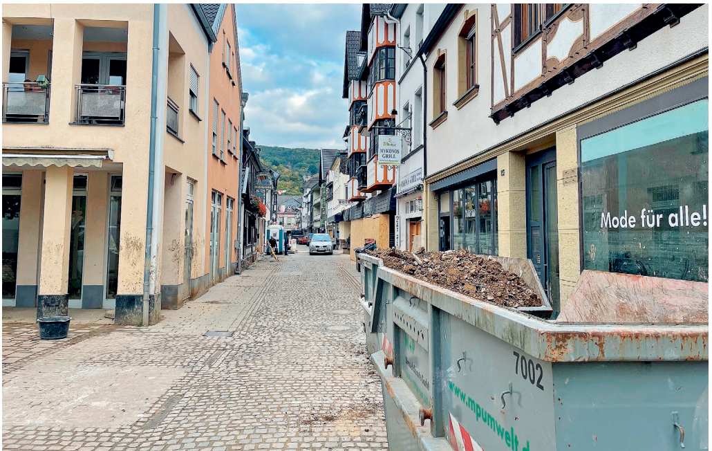
Baustellen statt Besucher: die Ahrhutstraße im Herbst
