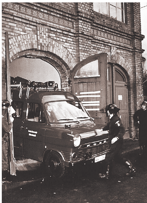
Altes Spritzenhaus mit dem ersten neuen Fahrzeug Anfang der 1970er-Jahre
