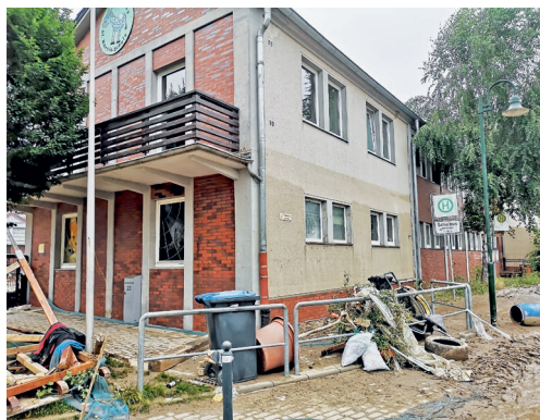
Unser Schulgebäude steht 200 Meter von der Ahr entfernt - trotzdem stand das Wasser auf dem Schulhof 3 Meter hoch.
