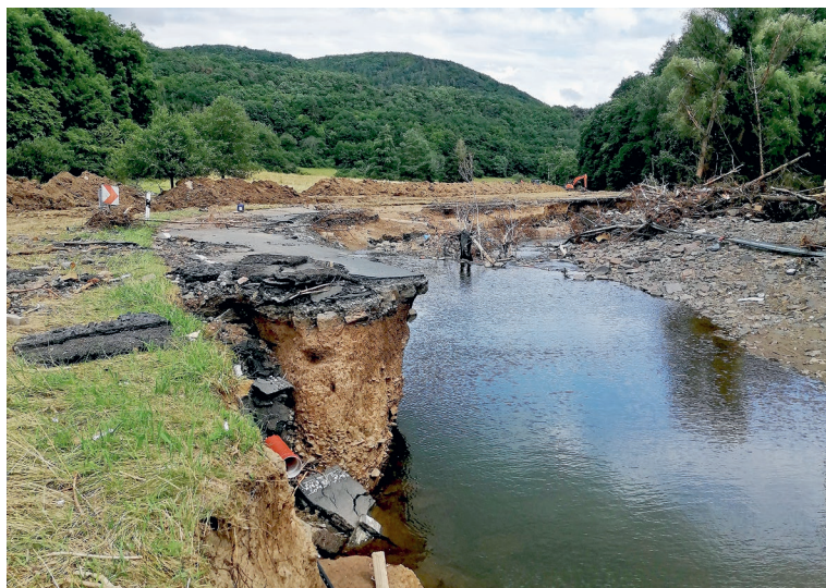
Die zerstörte Landesstraße 76 zwischen Binzenbach und Kreuzberg im Sahrachtal wurde auf einer Länge von rund 7 Kilometer wieder aufgebaut.
