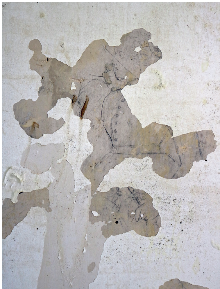
Durch die Fluteinwirkung freigelegte bauzeitliche figürliche Skizze im Thermalbadehaus im August 2021
