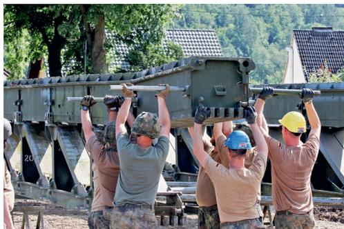
*Muskelkraft und Teamarbeit: Aufbau einer transportablen Behelfsbrücke vom Typ Medium Girder Bridge*
