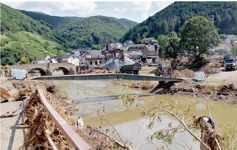
*In Rech wurde eine Panzerschnellbrücke über die Ahr errichtet.*
