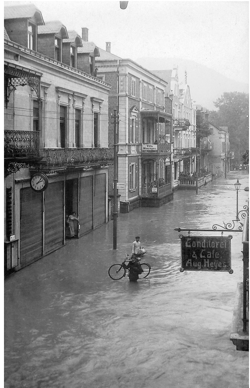
Bad Neuenahr: Die Poststraße unter Wasser
