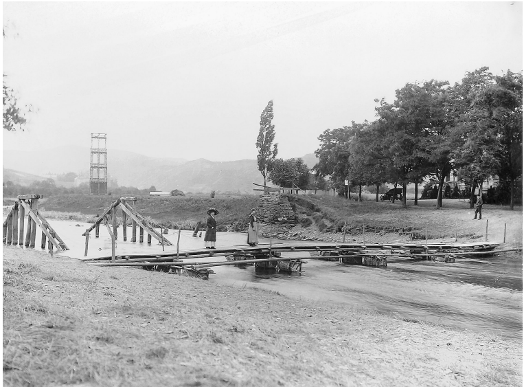
Ahrweiler: Notsteg nach Bachem
