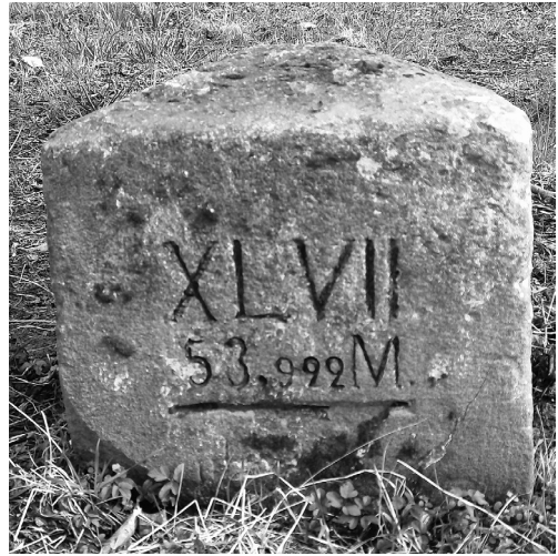
Myriameterstein XLVII: Landseite mit der Entfernungsangabe 470,000 km von Basel und (im unteren Teil, nicht ablesbar) 354,450 km bis Rotterdam (Hafen).
