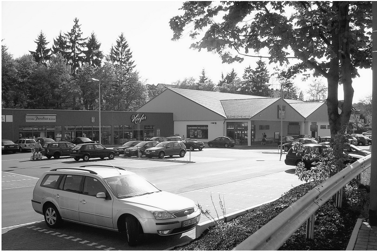
Fertiggestelltes Nahversorgungs- zentrum Brohltal, 2008
