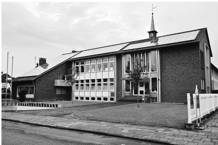
Moderne Bauweise und traditionelle Form: In der Sinziger Janusz-Korczak-Schule sind noch viele Stilelemente aus der Bauzeit erhalten.
