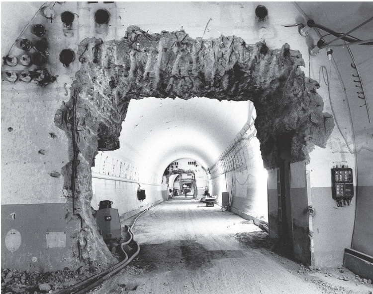
„Rückbau“ des Regierungsbunkers
