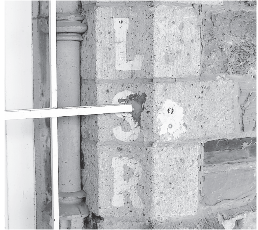
Die Inschrift „LSR“ (Luftschutzraum) ist noch ein Hinweis aus der Zeit des Zweiten Weltkrieges auf den Luftschutzkeller im Bahnhofsgelände von Bad Neuenahr.
