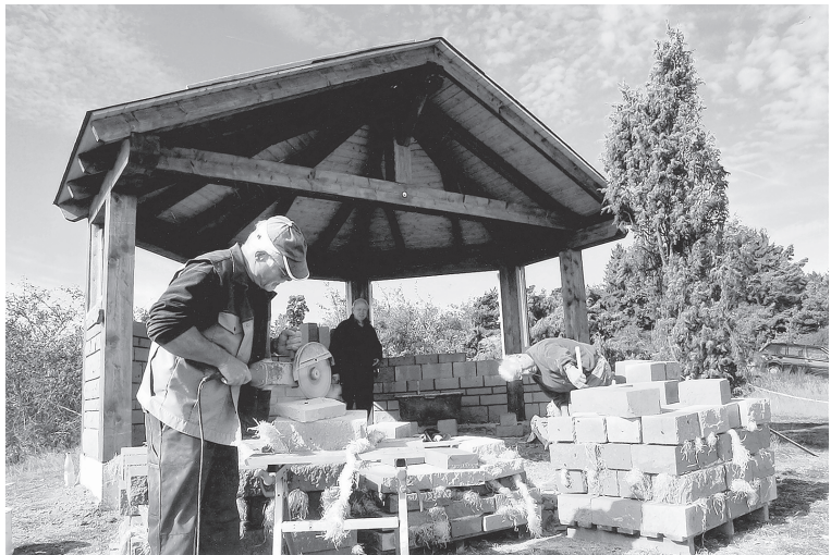
Bau der Wanderschutzhütte in der Waberner Heide
