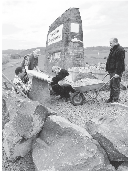
Arbeiten an der alten Seilbahn-Spannstation
