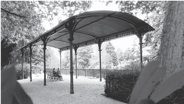
Teilstück der wieder aufgebauten Wandelhalle im Kurpark, 2008
