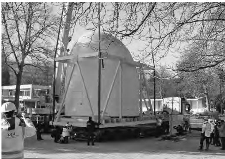
*Ende 2019 begann der Abriss. Die unter Denkmalschutz stehende Drehbühne und ihre Unterkonstruktion wurden mittels einer Stützkonstruktion von innen ausgeschalt und für einen sicheren Transport zum etwa 250 Meter entfernten Zwischenlagerplatz auf dem Gelände der historischen Milchkuranstalt vorbereitet.*
