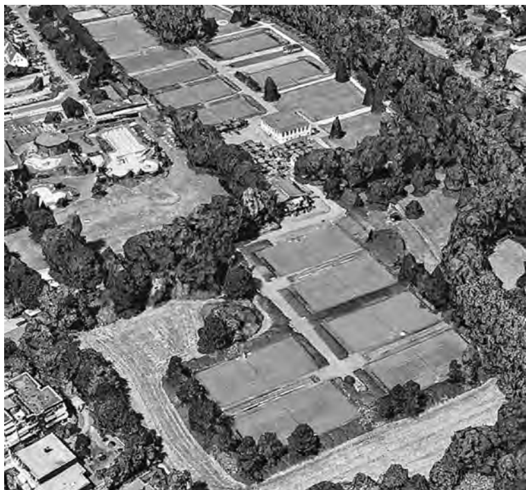
Die Tennisanlage des HTC 2016 aus der Vogelperspektive mit Clubhaus (Gebäude links) und Lenné-Schlösschen (Gebäude rechts)
