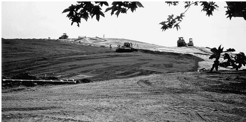
Deponie Remagen-Oedingen 2002: Geordneter Abfalleinbau im Deponiekörper. Die Deponien wurden 2001 bis 2003 oberflächengedichtet und befinden sich seitdem in der Nachsorgephase.
