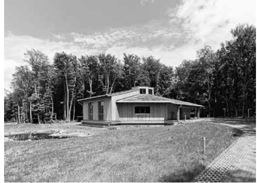
Vereint die drei Themenschwerpunkte Abfallwirtschaft, Energienutzung und Holzwirtschaft: das Gebäude der UmweltLern-Schule plus 2012
