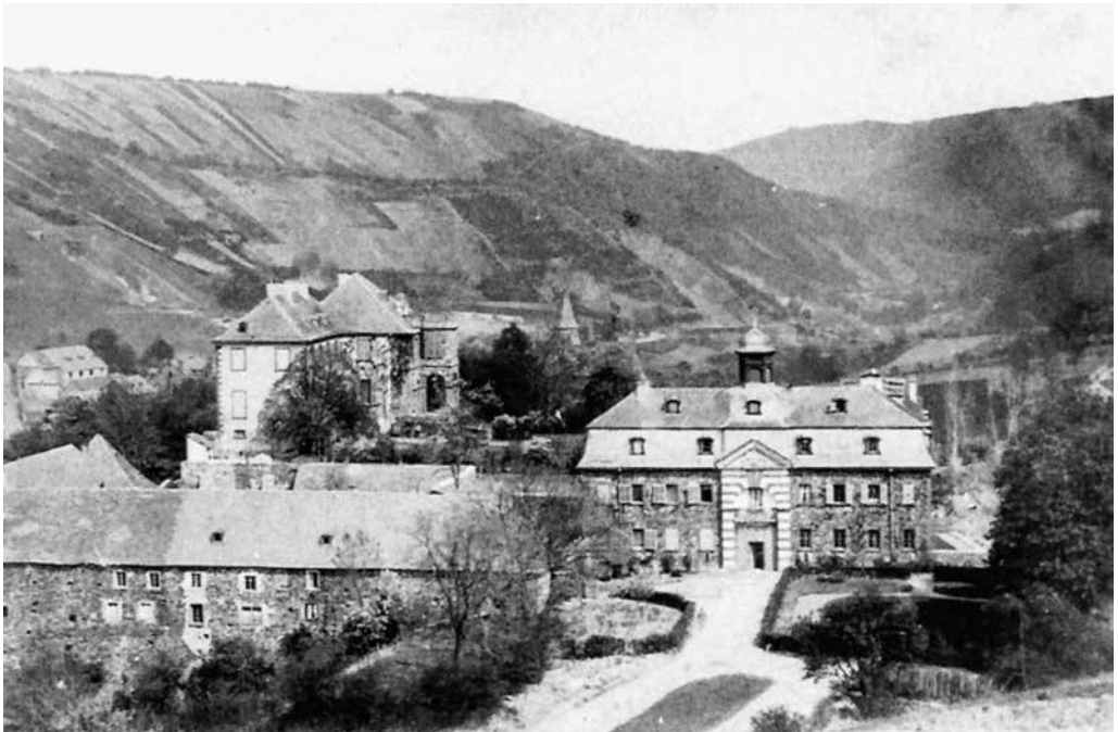
Dieses um 1920 aufgenommene Foto zeigt rechts die Kellnerei und Reste einer barocken Gartenanlage. Links vorne: die äußere Vorburg mit nachträglich hinein gebrochenen unregelmäßigen Fenstern. Direkt dahinter: nur undeutlich erkennbar die große Bruchsteinmauer der inneren Vorburg. Im Hintergrund: das Schloss und die damaligen Burgbrohler Weinberge
