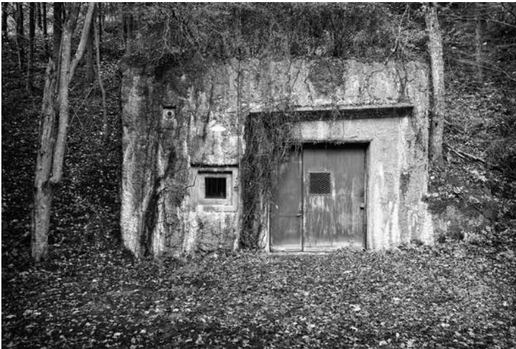
Versteckt im nordjütländischen Wald: der Eingang zum dänischen Regierungsbunker
