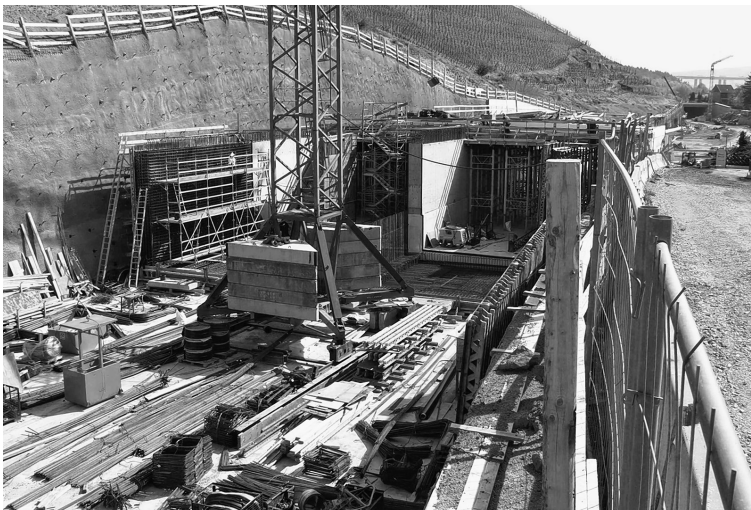
Impressionen von einer Großbaustelle: der Tunnel Muckental ...
