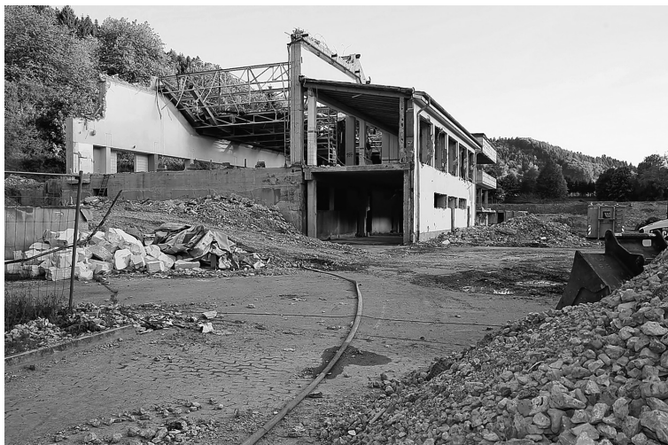
In Adenau: Wo 2018 Abbruch- arbeiten liefen, soll 2019 eine neue Kindertagesstätte entstehen.
