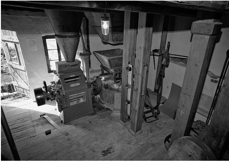
Die Mahlgruppe nach der Sanierung
