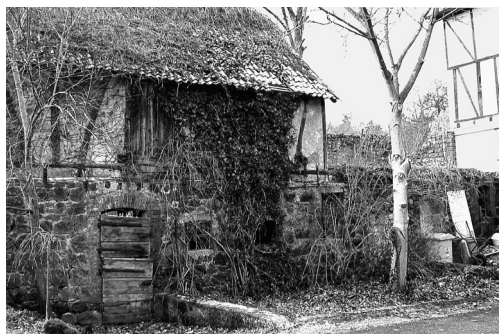
Zustand der Nebengebäude vor der Restaurierung
