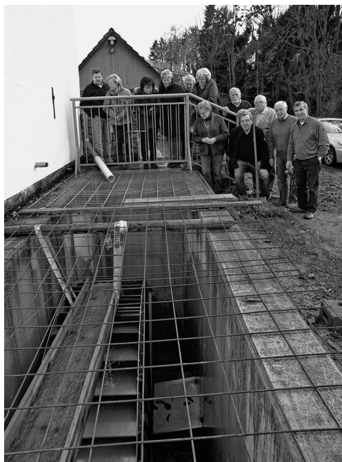
Das Mühlenteam nach Einbau des Wasserrads
