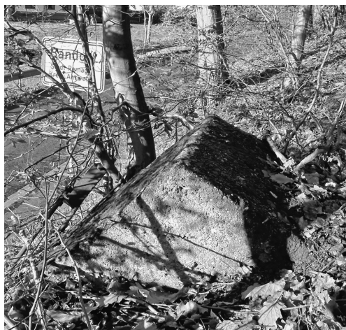
Im Hang oberhalb des Ortsschildes von Bandorf findet man noch die Betonverankerung für die Stützbalken der früheren Schutzbrücke.
