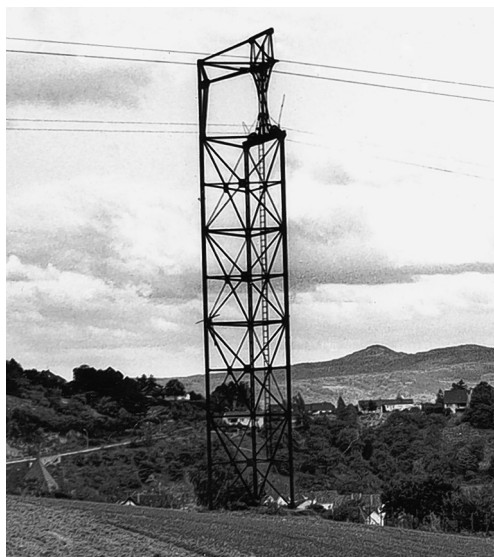
Stützpfiler zur Überspannung des Bandorfer Tals (Gemarkung Im Sonnenberg). Der Mast dürfte 10 m Höhe erreicht haben. Eine Leiter führte für Wartungszwecke hinauf zur Rollenkonstruktion. Das Tragseil befand sich oben, das Zugseil darunter.
