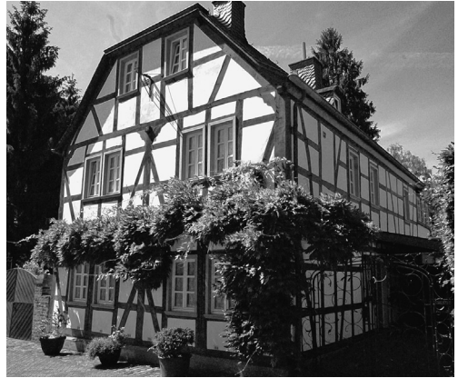
Das Fachwerkhaus in der Eulengasse stand schon vor 1827.
