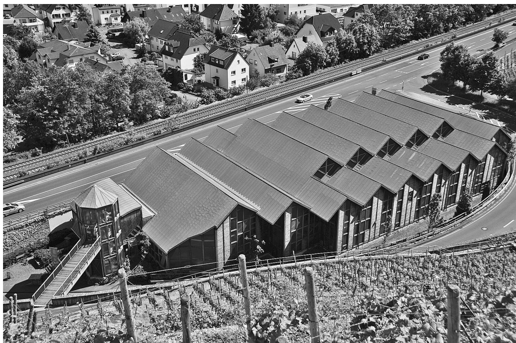
Gesamtansicht des Museumsbaus Roemervilla, der überwiegend aus Holz und Glas errichtet wurde.
