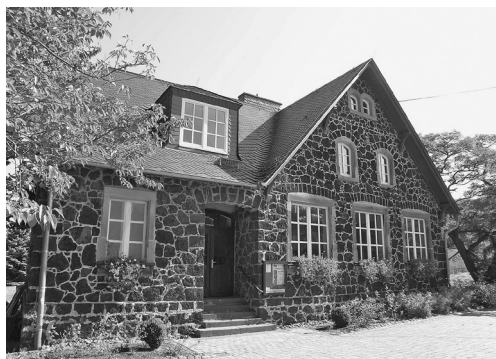
Die ehemalige Schule Niederzissen-Rodder ist heute ein viel genutztes Dorfgemeinschaftshaus.
