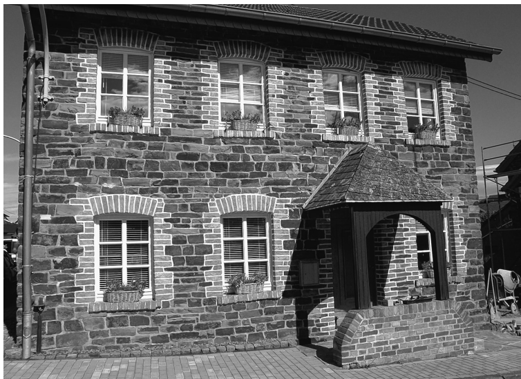
Vorbildliche Sanierung eines regionaltypischen Hauses in Sierscheid
