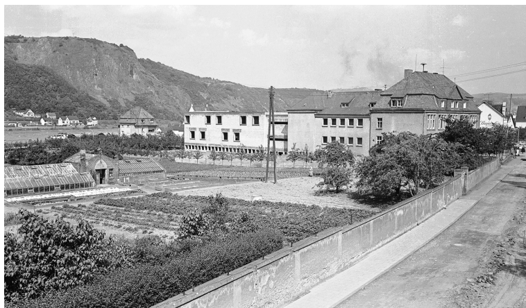
Die katholische Volksschule Remagen, heute die St. Martin Grundschule, wird 1910 eingeweiht. Bis 1958 befinden sich hier auch die zwei Klassen der evangelischen Schule. Auf dem Bild das Gebäude mit dem im Rohbau befindlichen 2. Erweiterungstrakt. Dieser wird am 29. März 1968 eingeweiht.
