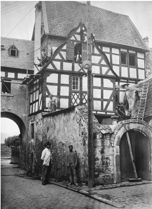
Während der Instandsetzungsarbeiten 1907/8 wurde auch der störende Lampenmast entfernt.
