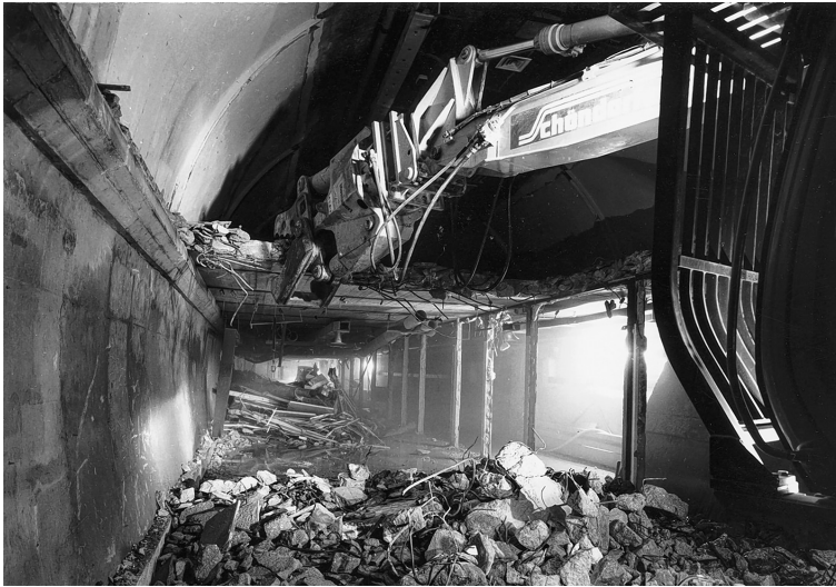
Rückbau des Regierungsbunkers
