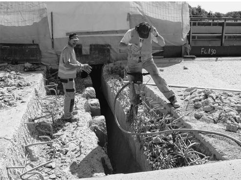
*Neu eingesetzt werden hier die Spanner der Übergangskonstruktionen, die eine eventuelle Ausdehnung der Brücke bei Hitze bis zu 52 Zentimeter auffangen können.*
