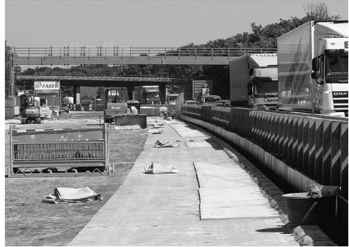
*Während der westliche Fahrbahntrog saniert wurde, lief der gesamte Verkehr über den östlichen Trog. Im Grunde sind es zwei Brücken, denn die beiden Fahrbahnen verlaufen auf jeweils unabhängigen Trögen.*
