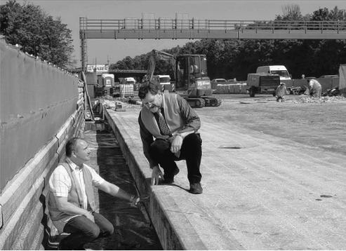
*Dipl.-Ing. Michael Palm (r.) vom Autobahnamt Montabaur und Dipl.-Ing. (FH) Rudolf Kahlenberg (l.) überwachten die Bauarbeiten. Gerüstbauer hatten zur Sicherheit an der westlichen Brückenseite ein Trag- und Montagegerüst unter die Fahrbahnplatte gehängt.*
