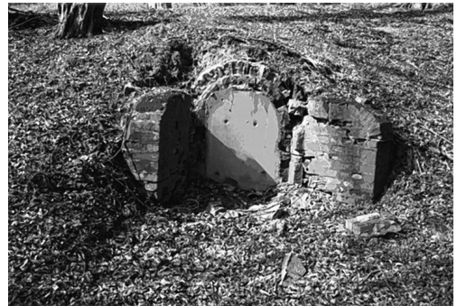
Verschlossenes Stollenmundloch in der „Meisenkaul“
