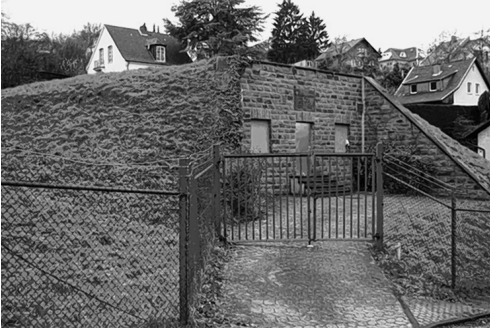
Der 1983 in Betrieb genommene Hochbehälter „Drachenfelsweg“
