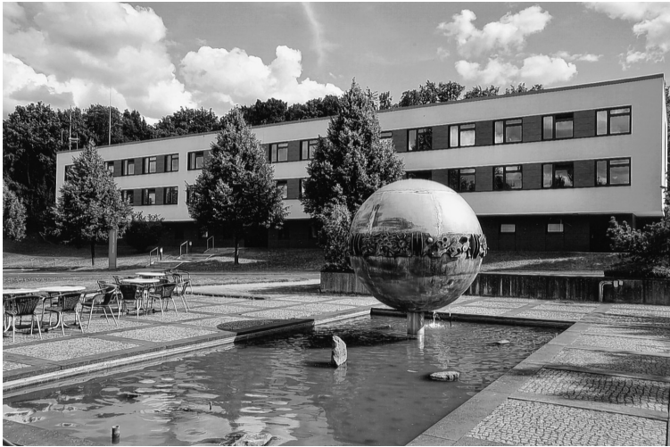
Die Seminar- und Schulungsgebäude der AKNZ, 2013
