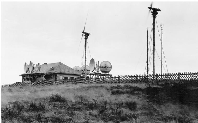
kraftanlagen installiert. Mit ihnen sollte die Stromversorgung der Richtfunkstelle auf dem Schöneberg sichergestellt werden.
