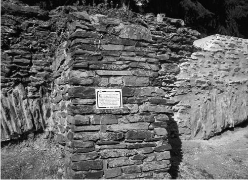
Reste der Sinziger Stadtmauer
