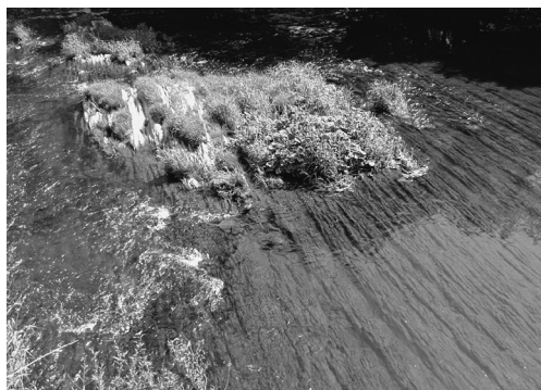
Neu eingerichtete Raustrecke bei Bad Bodendorf – zur Erleichterung des Wanderfischaufstiegs
