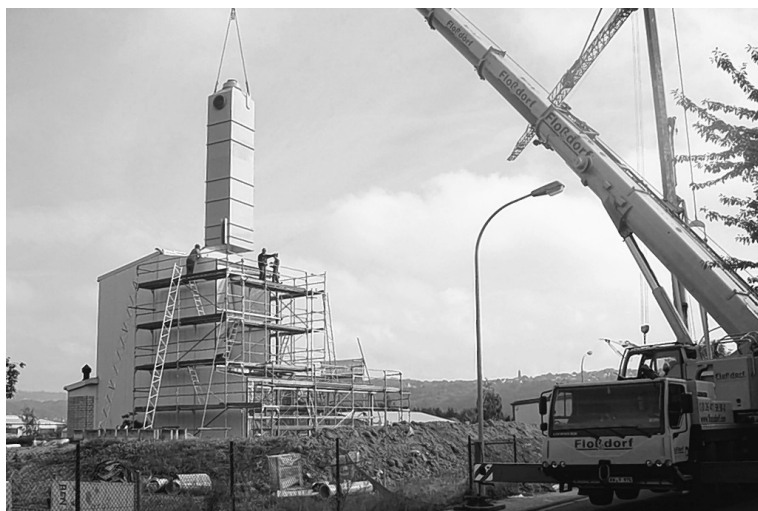
Einbau des zweiten Riesler-Turms in Sinzig
